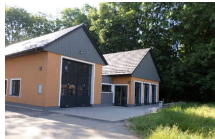
Neubau eines Vereins- und Feuerwehrhauses Reichardtswald
